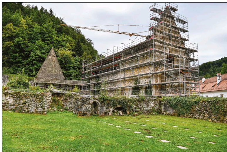
Pogled na gradbišče po postavitvi gradbenih odrov iz severozahodne strani (ZVKDS, OE Celje, fototeka; foto: Matija Plevnik)
