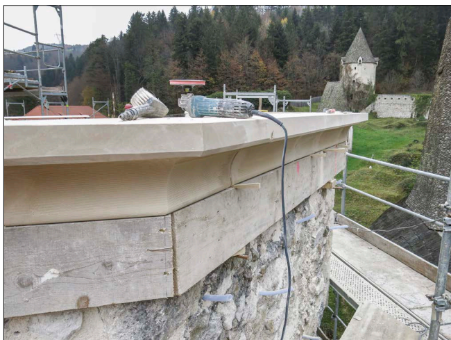
Detajl namestitve novih kamnitih elementov strešnega venca na Otakarjevo kapelo
