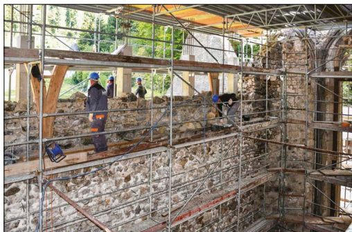
Ponovna pozidava Zadnikarjeve stene, pogled iz notranjščine proti severovzhodu
