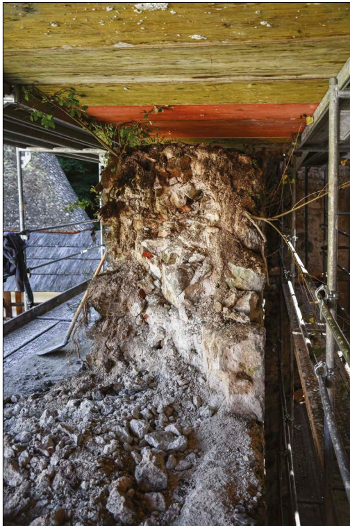
Nadaljevanje razdiranja Zadnikarjeve stene v višini delovnega takta, pogled proti vzhodu
