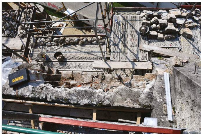
Razdiranje prvega polja južne stene po kampadah, pogled z vrha
