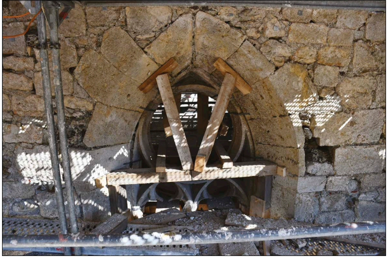
Opiranje in podpiranje gotskega okna drugega polja južne stene ladje
