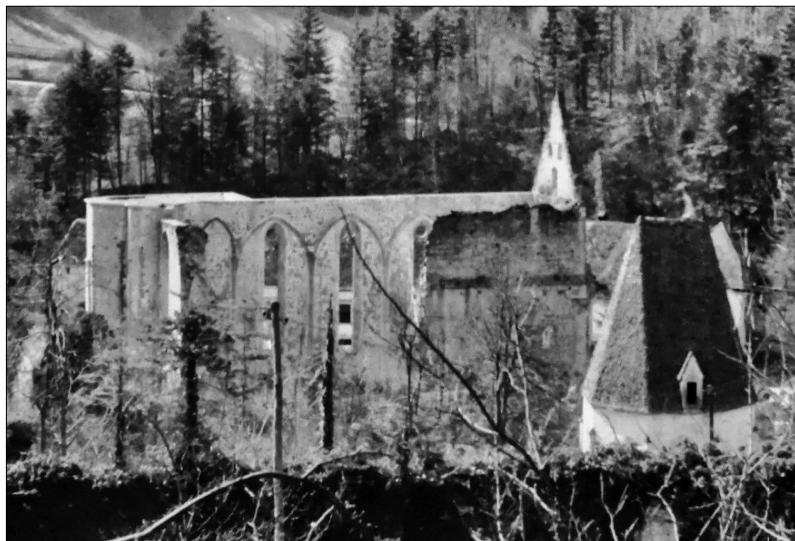
Pogled na deloma sanirano zidovje nekdanje samostanske cerkve pred ponovno gradnjo podrtega dela severne stene, 1965 (foto: Irena Sapač)
