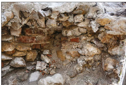
Sonda prvega polja vrha južne stene, stanje veziva in gradnikov sredice
