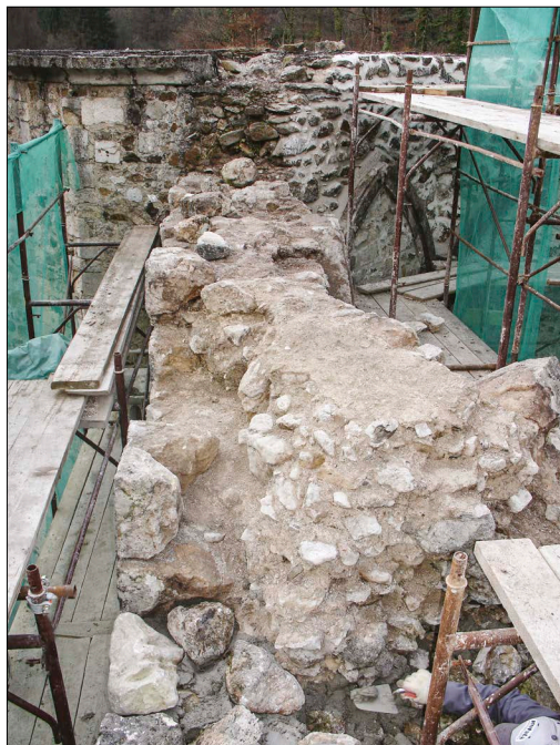
Ob konservatorskih posegih leta 2005 opazen zalom sredice, ki namiguje na poligonalnost severozahodne stranice prezbiterija (ZVKDS, OE Celje, fototeka; foto: Bogdan Badovinac)
