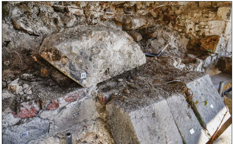
Najdena spolija (kamnita krovna plošča opornika) ob razdiranju stika prvega polja južne stene ladje in drugega opornika
