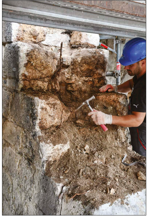
Čiščenje prhlega veziva in korenin ob razdiranju vrha tretjega opornika južne stene ladje
