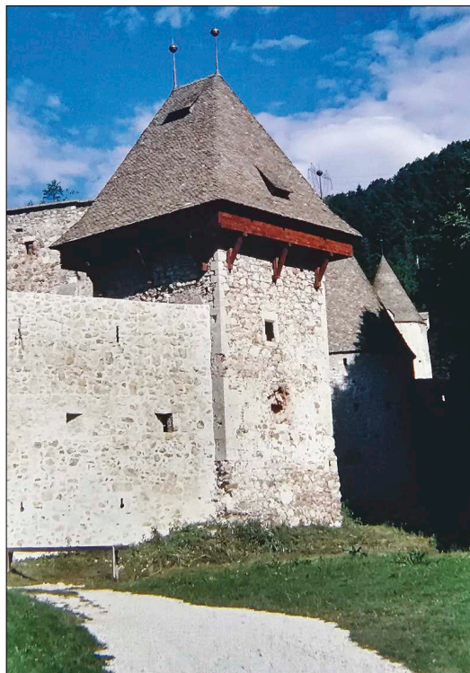
T. i. Ribji stolp po avtentični rekonstrukciji strešne konstrukcije, 1996 (foto: Igor Sapač)
