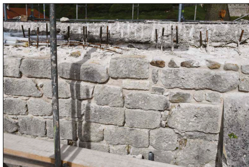
Tretje polje vrha južne stene ladje po ponovni pozidavi
