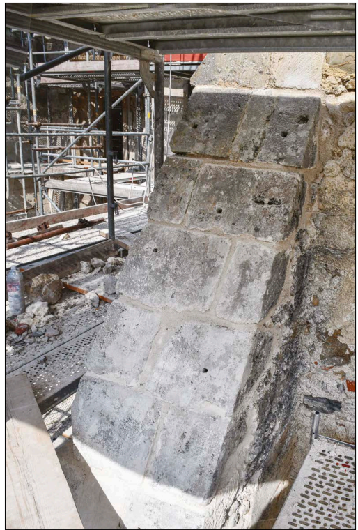
Vrh zahodnega opornika na južni steni Otokarjeve kapele po ponovni pozidavi
