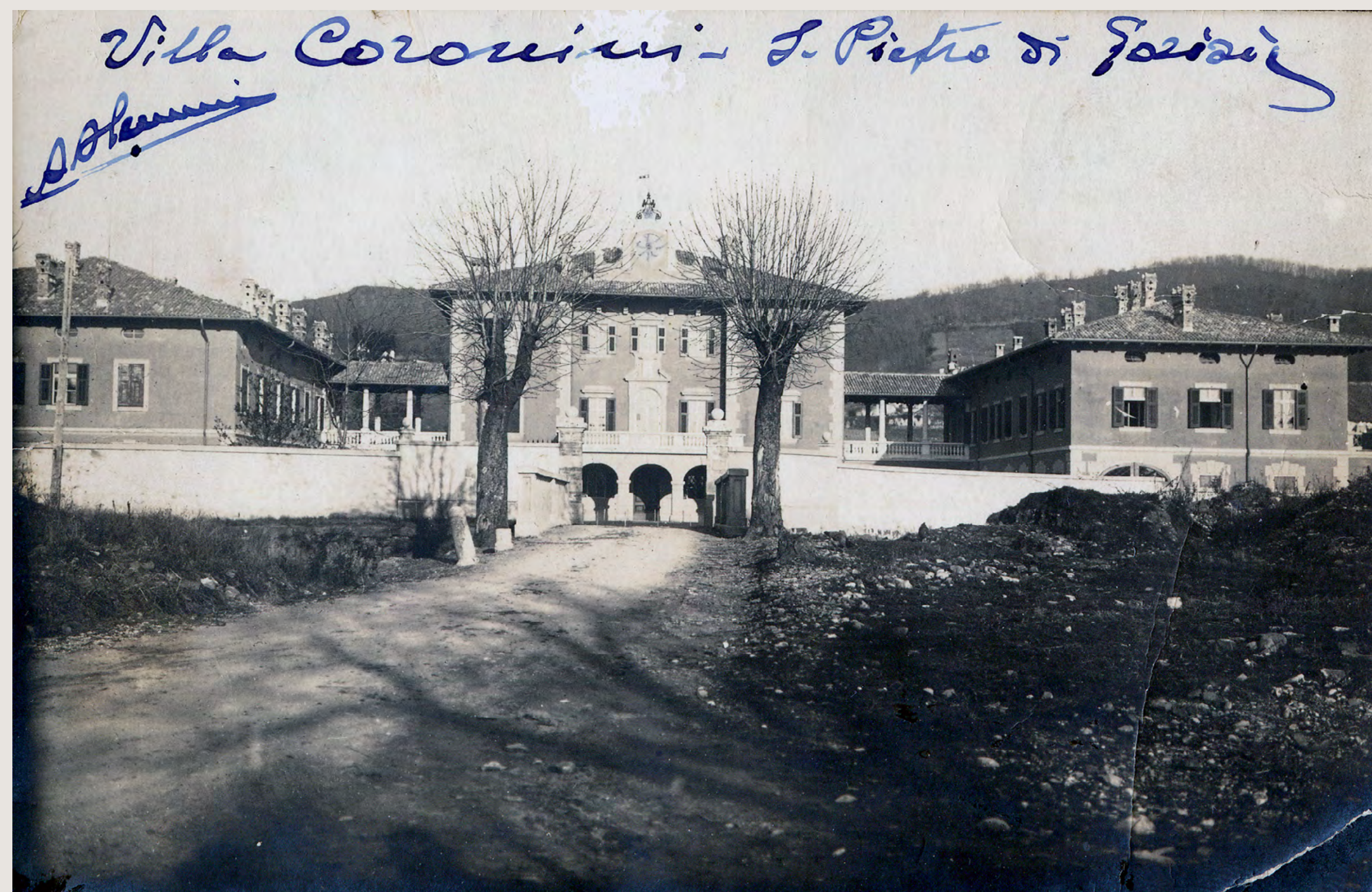
Šempeter pri Gorici, palača Coronini po obnovi (Vir: PANG)
