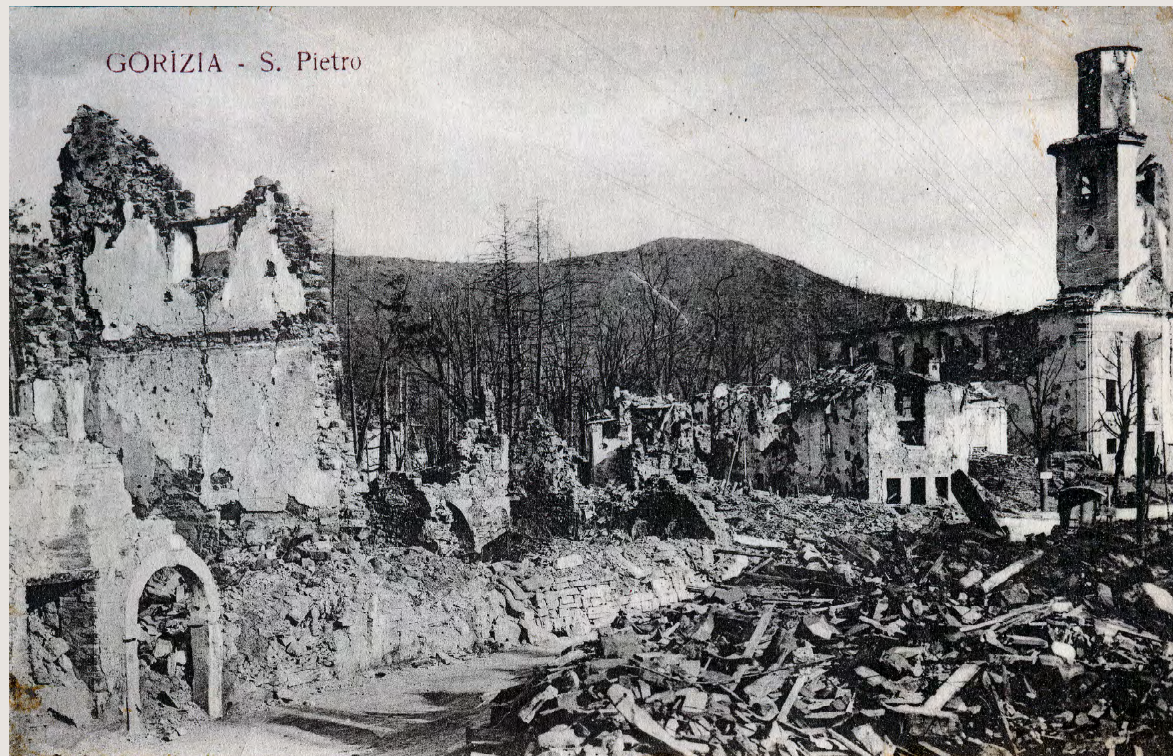
Šempeter pri Gorici, porušena glavni trg in cerkev Sv. Petra (Vir: PANG)
