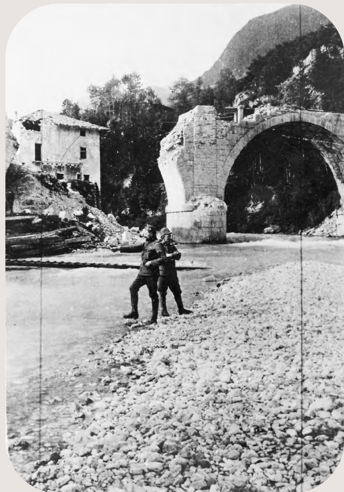
Porušen most čez Tolminko pri Tolminu
