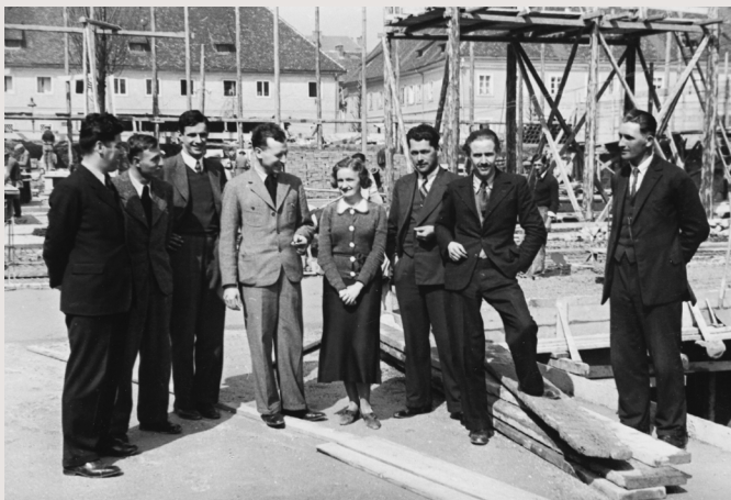
Gradbena inženirka Sonja Lapajne na gradbišču NUK-a v Ljubljani, okoli 1936. Levo v beli obleki stoji arhitekt Vinko Glanz (Zasebni arhiv Antona Smoleja, foto: Lojze Šmuc, last).
